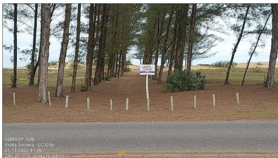
Figura 30 - Instalação de barreiras físicas com fins de impedir o acesso de veículos na faixa de areia.
