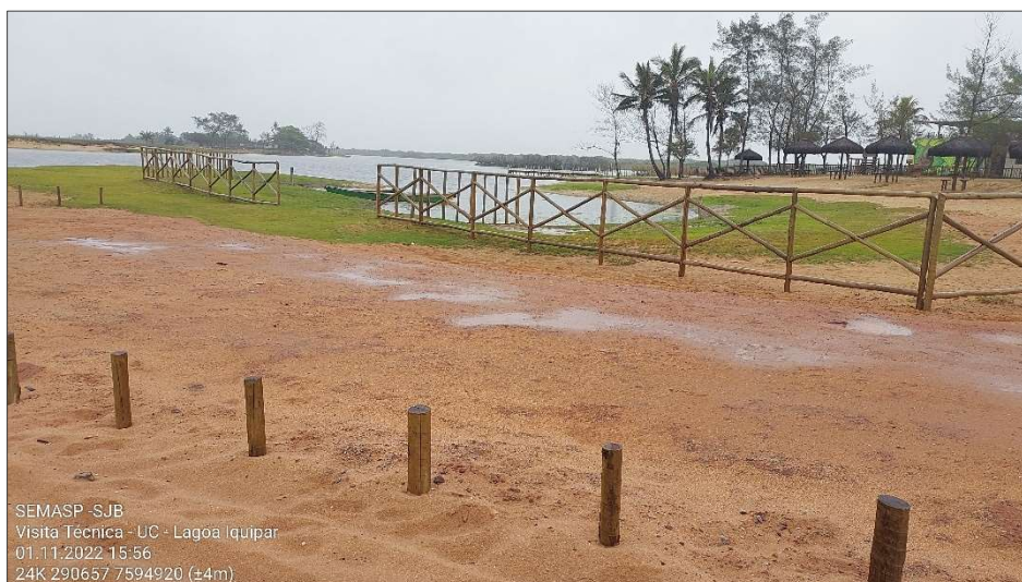
Figura 35 - Instalação de barreiras para impedir o trânsito de veículos na faixa de areia do entorno da Lagoa de Iquipari.
